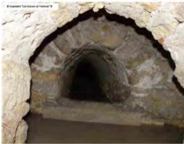
Galerie souterraine, Source : Association « Les sources de Fontenay »
