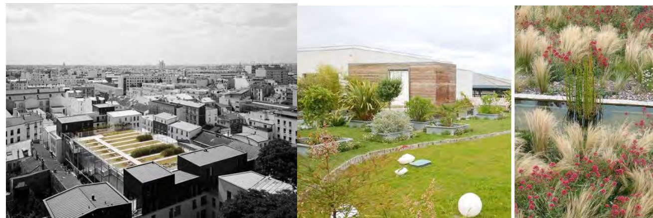
Figure 218 : Exemple de végétalisation de toits (Source : Atelier Castro Denissof et associés, CPAUP du quartier des Paradis)
