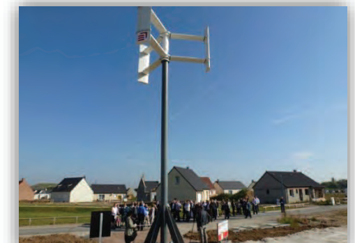
Éolienne à axe vertical, écoquartier de la Marlière (Courcelle-lès-Lens)
