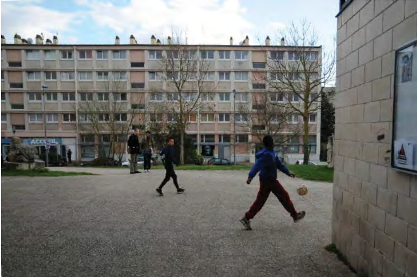
Figure 96 : Parvis de la Maison de quartier (Source : Atelier Castro Denissof et associés, 2017)
