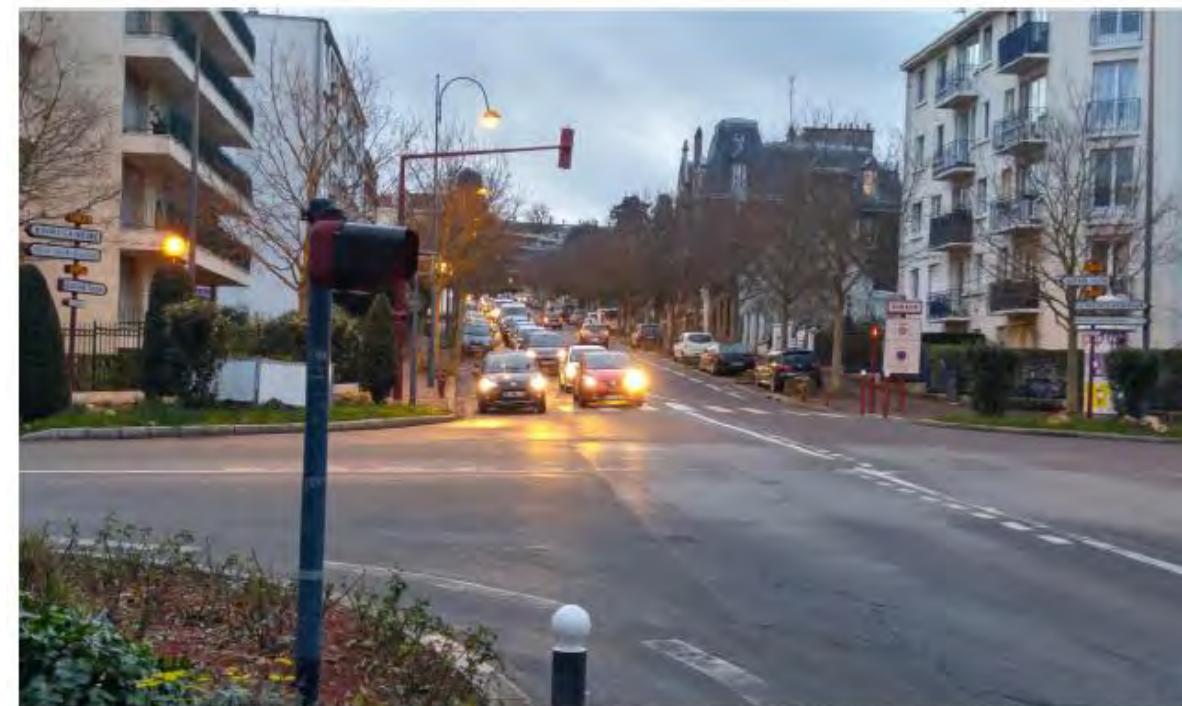
Figure 134 : Entrée Sud du carrefour RD67/RD75
