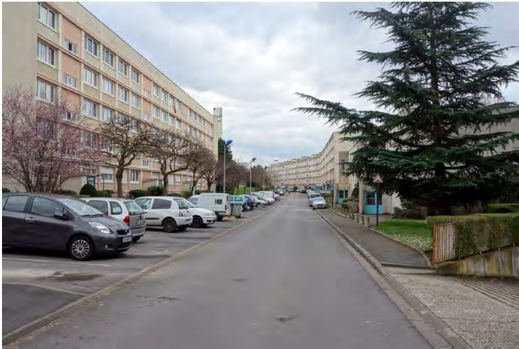
Figure 124 : Immeubles d'habitat collectif en R+5 caractérisant le quartier des Paradis (Source : Atelier Amar ; 2017)
