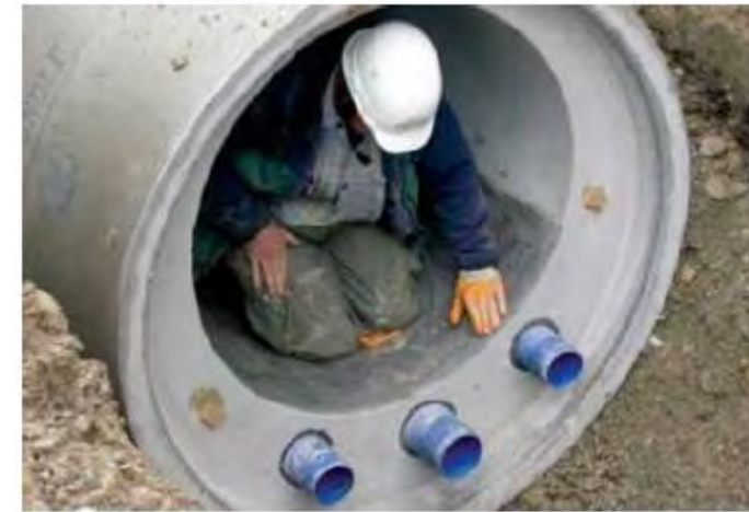
Figure 185 : Canalisation préfabriquée avec échangeur de chaleur intégré Source : Guide pour les maîtres d'ouvrages et les communes, OFEN
