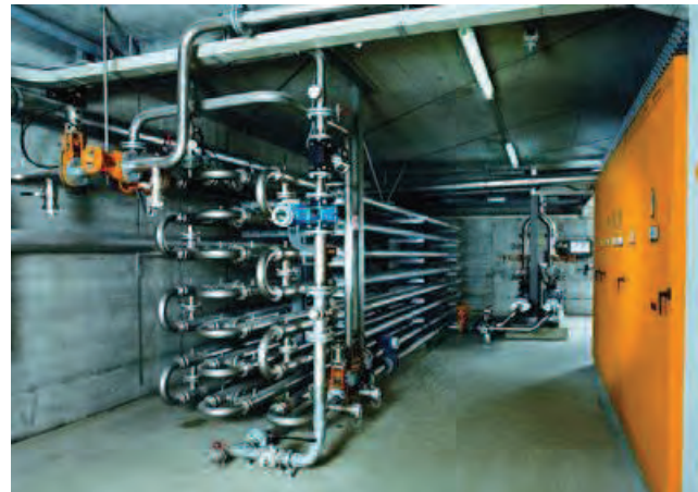
Figure 30 : Échangeur tubulaire en sortie de STEP (Lyonnaise des Eaux, ISTINOX, ANTEA)
