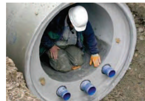
Figure 24 : Canalisation préfabriquée avec échangeur de chaleur intégré (Source : Guide pour les maîtres d'ouvrages et les communes, OFEN)
