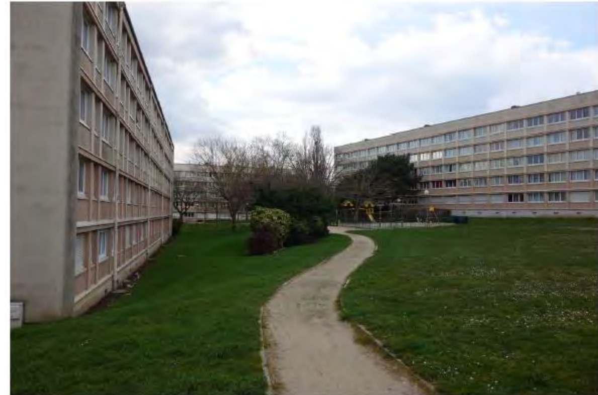
Figure 149 : Cheminement piéton au sein du quartier des Paradis (Source : Diagnostic pour le projet de renouvellement urbain du quartier des Paradis, Castro Denissof et associés, 2017)
