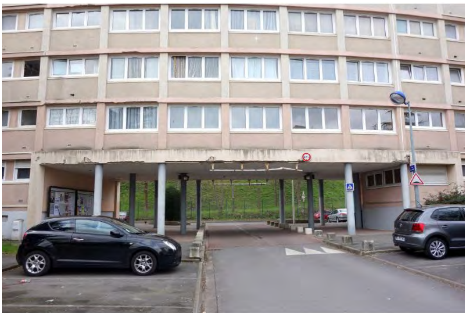
Figure 125 : Une des entrées dans le quartier sous forme de porche sous un immeuble renforce l'impression d'enclavement du quartier (Source : Atelier Amar, 2017)
