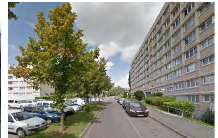
Rue Paul Verlaine gestion des talus en pied de bâtiment
