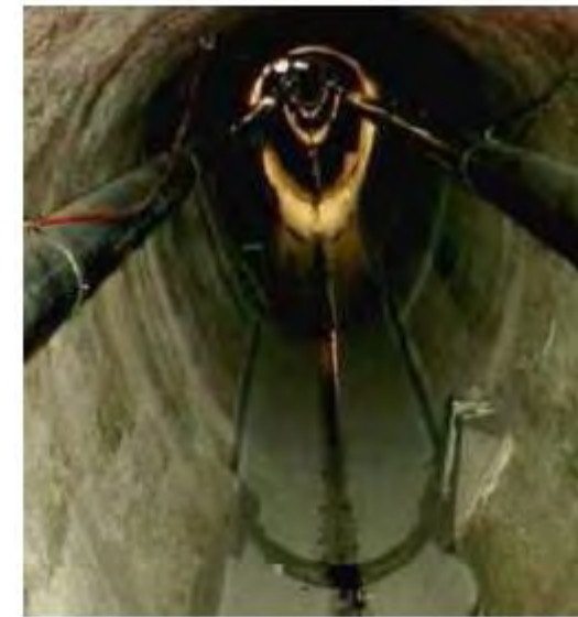
Figure 186 : Echangeur installé dans un ovoïde existant (Rabtherm), échangeur pour collecteur existant (Uhrig) Source : Lyonnaise des Eaux
