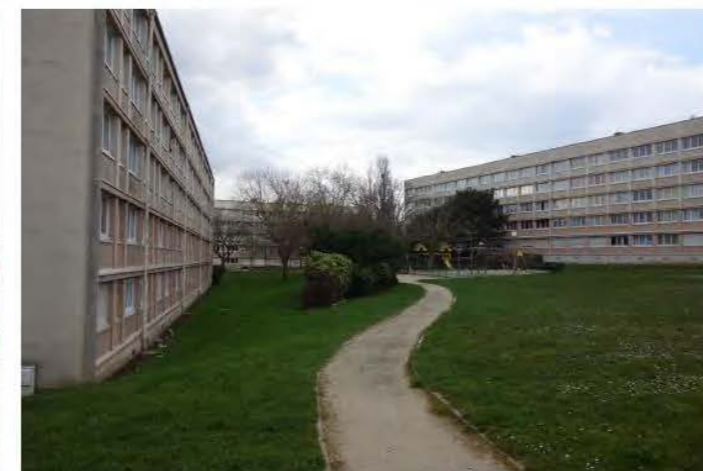
Parc ouvert du quartier des Paradis
