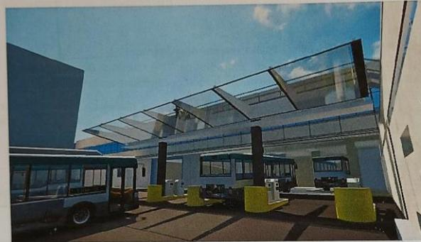
Les bornes de charge sont installées sur des semelles en bétons de forme ovales. Un auvent métallique vitré vient protéger les bornes et les chauffeurs des intempéries. Pour protéger l'ensemble de l'encastrement, des musoirs en béton armés, de couleur jaune, sont disposés à l'avant des semelles de support.
